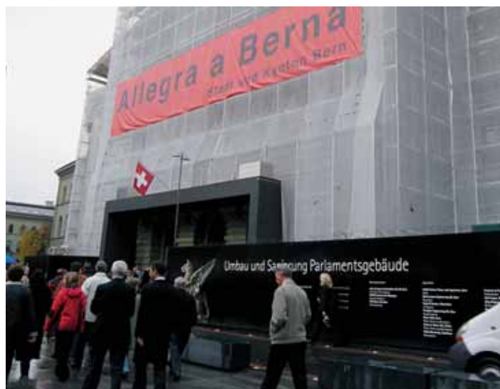
Das Bundeshaus im Baugerüst.
